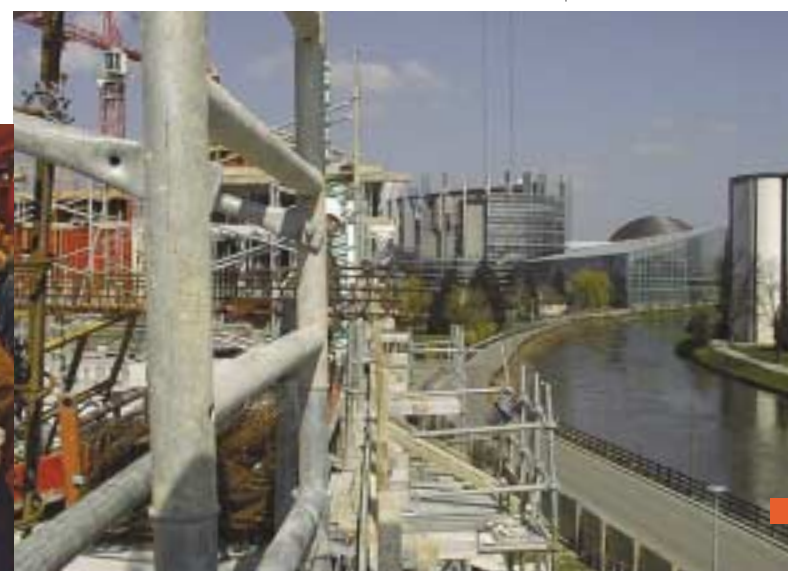
Baustelle des neuen ARTE-Gesellschaftssitzes neben dem europäischen Parlament
